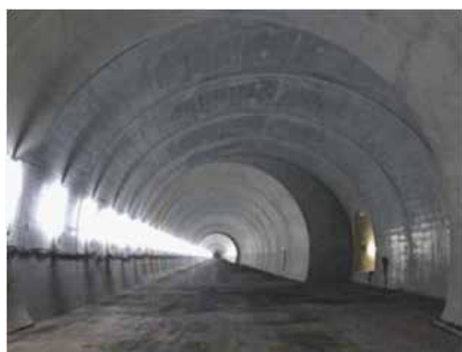
【国道440号 地芳トンネル】
